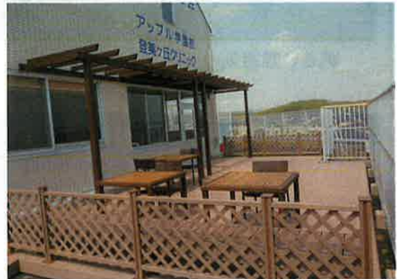
屋上「いこいの広場」、園芸も楽しんでいます。
